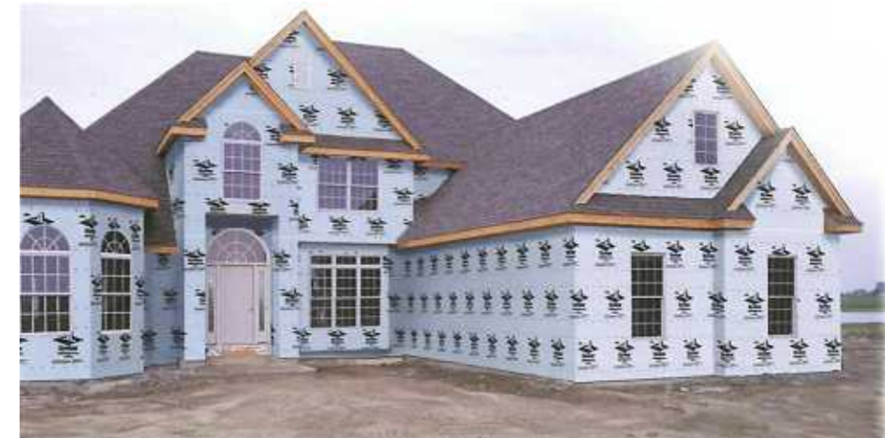
全体の施工状態
